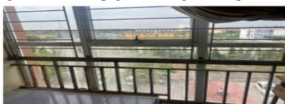
Hình 3.13. Lan can sắt và khung cửa thép bị gỉ trong phòng học giảng đường nhà B
