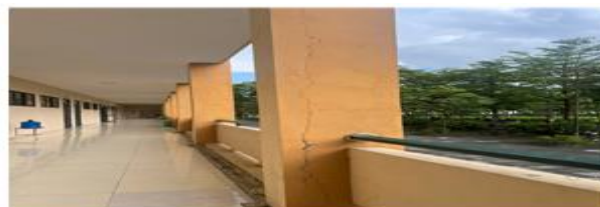
Hình 3.18. Cột hành lang khoa Y Dược nhiều vết nứt dọc
