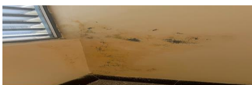
Hình 3.19. Khu vực tiếp giáp nền tường và cầu thang tầng 3-4 khoa Y Dược
