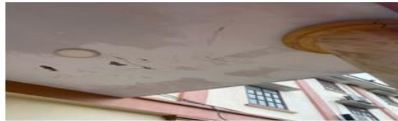
Hình 3.7. Vết nứt sâu và loang lổ tại mái hiên sảnh nhà hiệu bộ A
